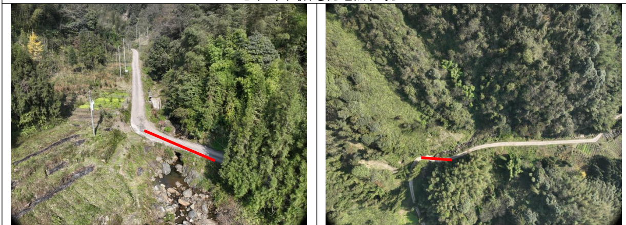
思经村新政小桥建设地点现状
