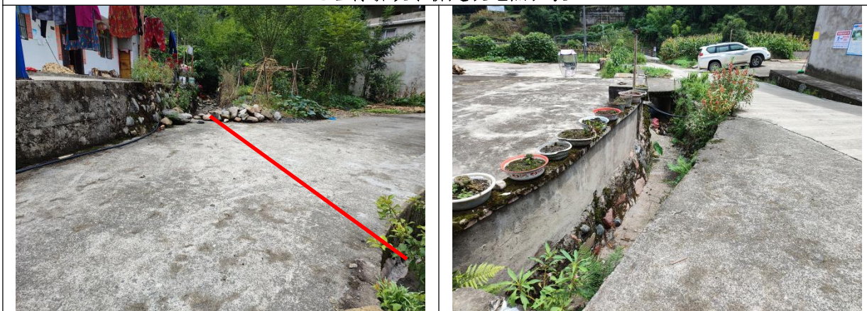
鱼泉村3组道路涵洞建设地点现状
