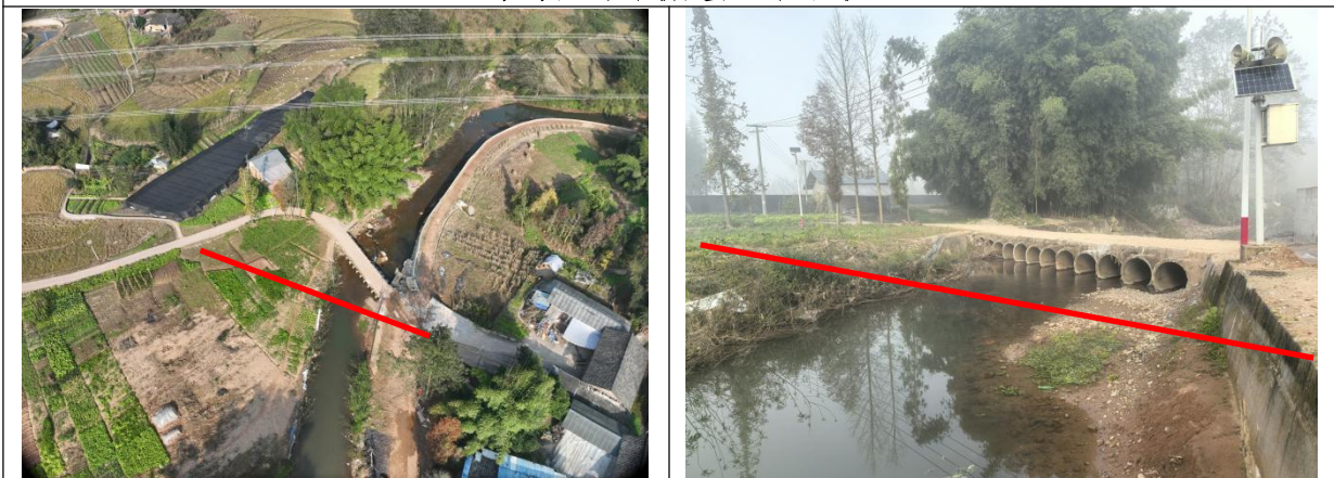
巨兴坝二号小桥建设地点现状
