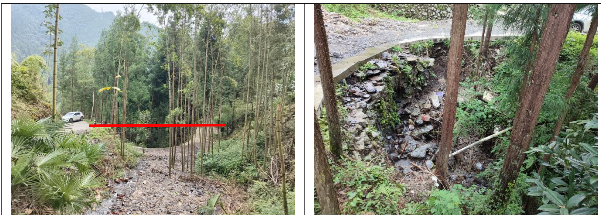
毛家沟小桥建设地点现状
