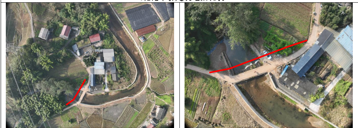
巨兴坝一号小桥建设地点现状
