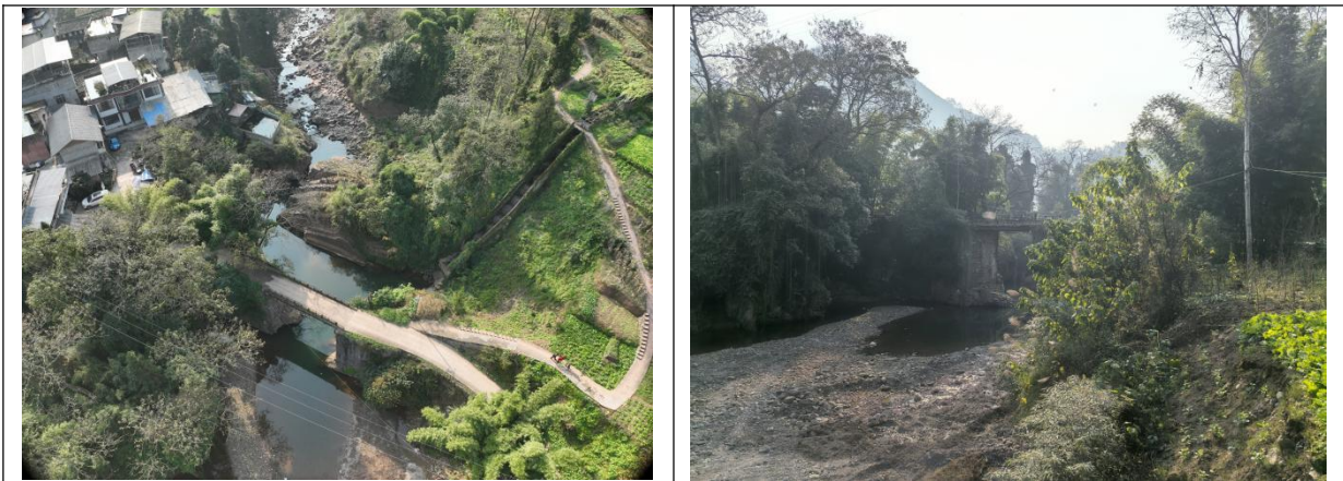
飞花沱中桥建设地点现状
